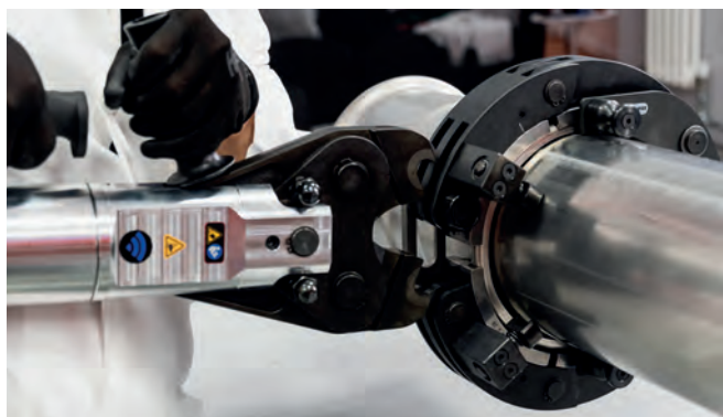
Figura 39- Assemblaggio pressatura n°1
