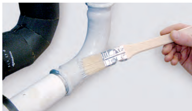
Figura 42 - Verniciatura raccordi e tubazioni con primer
