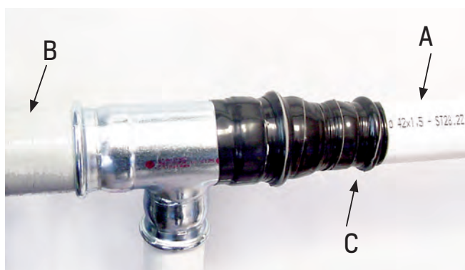
Figura 44 – Protezione agenti corrosivi esterni
