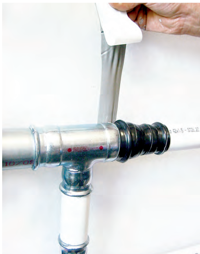
Figura 43 – Protezione dei raccordi con nastro isobutilico
